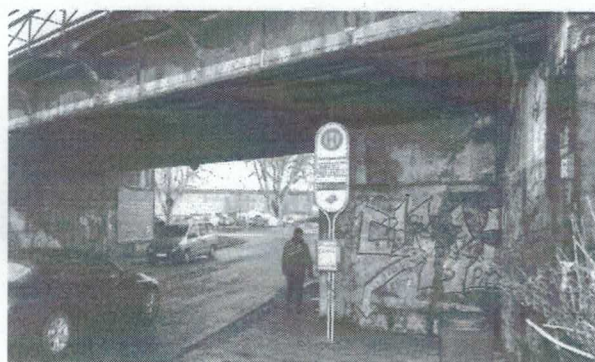
Bereich an der Eisenbahnbrücke in der Küppersbuschstraße soll den.
